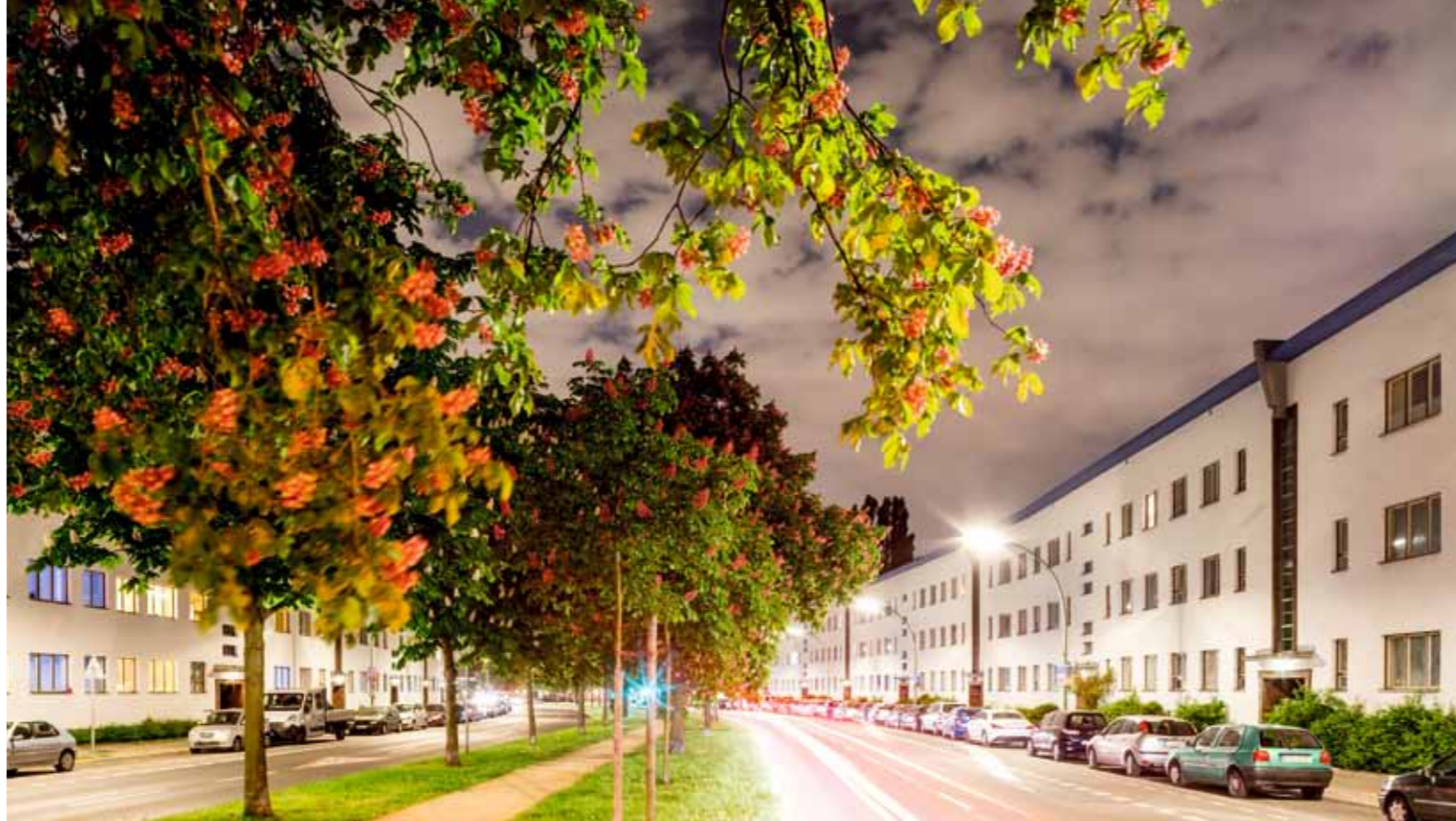
Seit 2011 versorgt GETEC die Weiße Stadt aus einem BHKW. Die hocheffiziente Anlage erzeugt nicht nur Wärme, sondern gleichzeitig auch Strom
