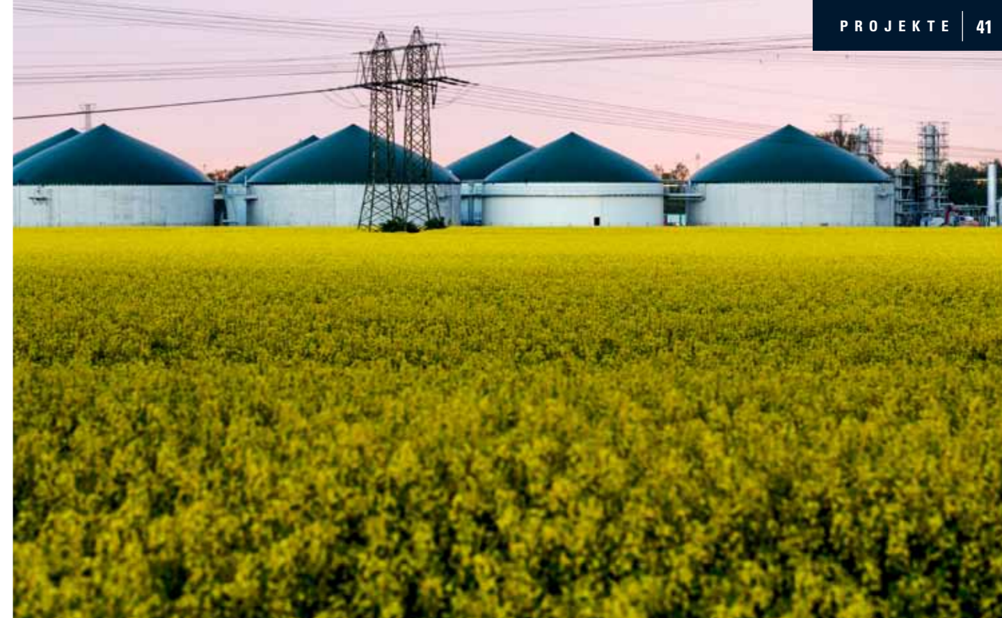
Energiehaltige Nutzpflanzen werden in der Bioraffinerie Niederndodeleben zur Strom- und Wärmeerzeugung zu Biogas vergoren
