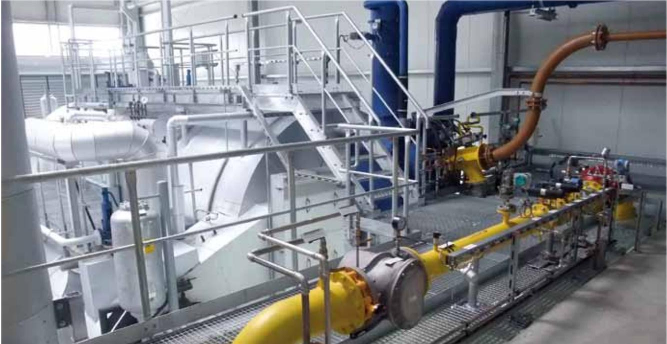
Um die Energieversorgung der AllessaChemie GmbH in Frankfurt-Fechenheim auf eine neue Basis zu stellen, haben die GETEC-Ingenieure ein innovatives Konzept entwickelt und realisiert. Die Grundversorgung des Chemiestandortes übernehmen zwei moderne Großwasserraumkessel mit effizienter Braunkohlent Staub-Feuerung, die von GETEC im Contracting-Modell errichtet wurden. Mit einer Nennwärmeleistung von je 9,2 MW decken sie den maßgeblichen Teil der Dampfversorgung für AllessaChemie.
